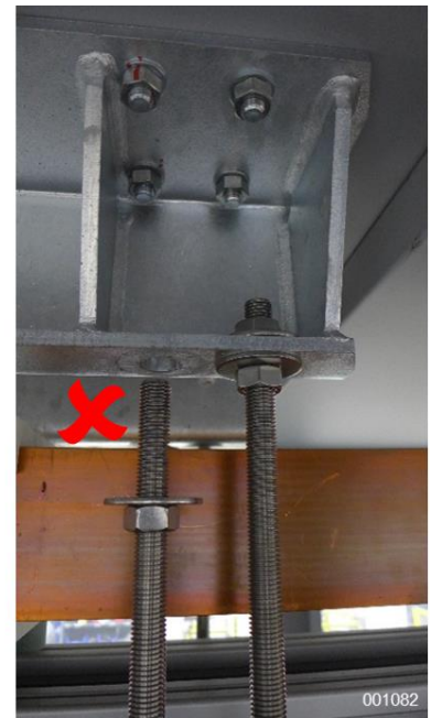
Forskruening løsnet
