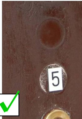
Abb. 14: In Ordnung. Kleinere Unregelmäßigkeiten der Oberfläche und in deren Farbgebung
